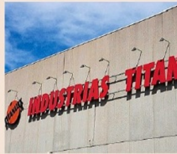
Instalaciones de Titan en El Prat (Barcelona).
