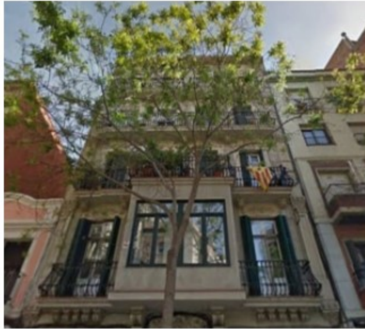
El edificio 'tokenizado' por RealFunda en Barcelona.
